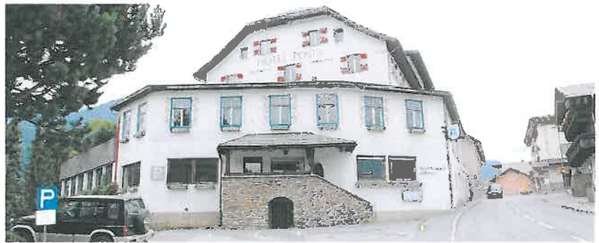
Seit Oktober 2010 ist das Hotel Post geschlossen. Bauherr Walter Stoll will noch heuer im Inneren mit den Umbauarbeiten beginnen. Foto: Paschinger
