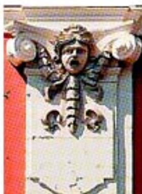
Die Fensterverzierungen werden restauriert.
