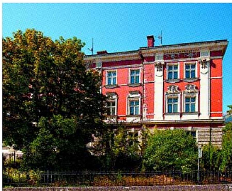
Selt mehr als 100 Jahren prägt sie das Stadtbild von Imst: die von 1903 bis 1905 errichtete „Alte Sparkasse“ in der Carl-Pfeiffenberger-Straße.
